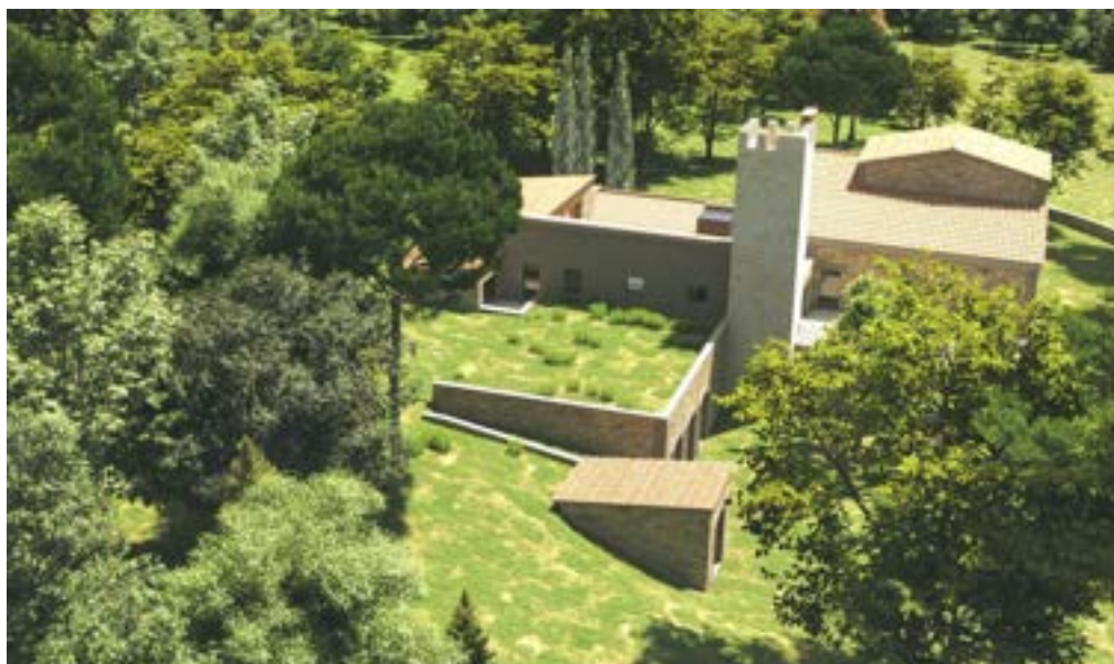
VISTA DES DEL SUD-OEST DE CAN MERCADER
